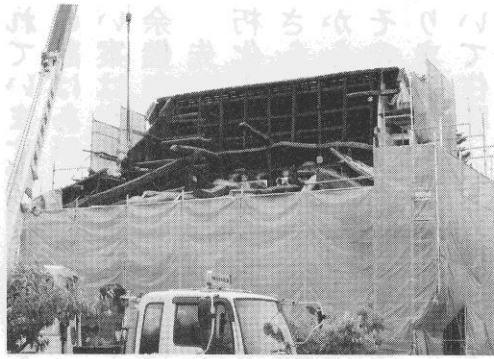
5月23日小屋組み解体
