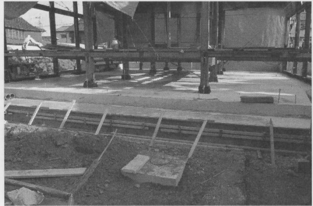
7月30日 床コンクリート
