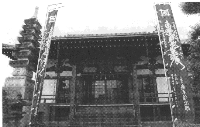
改修・整備された本堂
